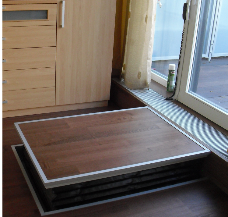
Plattform in Grube für eine glatte Oberfläche in der unteren Haltestelle
