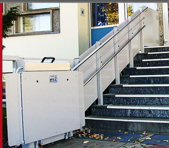
Fahrbahnverkleidung Alublech
